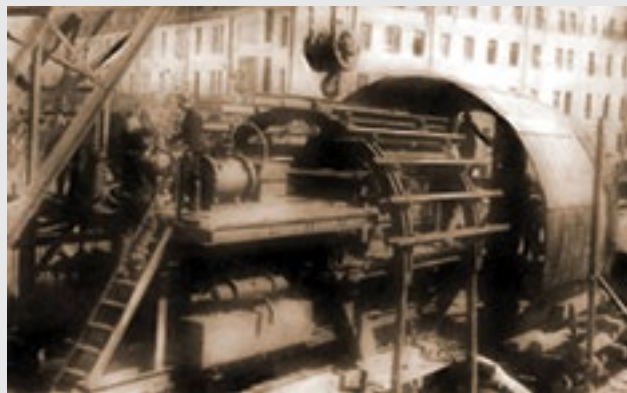
1935-36 гг. Для строительства первой очереди Московского метрополитена НКМЗ изготовил 6 проходческих щитов диаметром 10 м.
